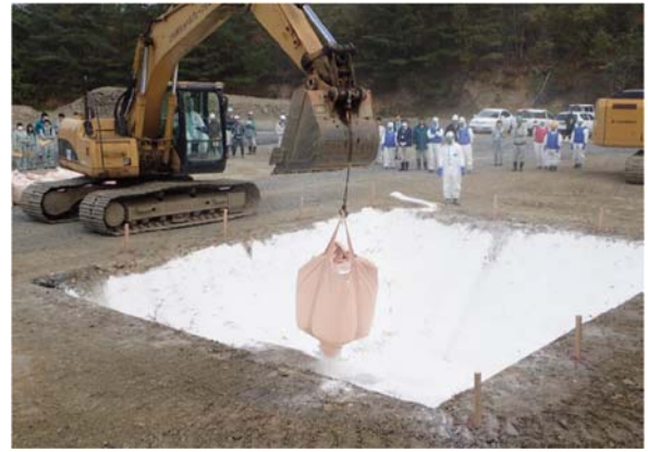
▲バックホウを用いて石灰を散布しています
