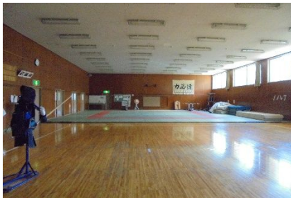
柔剣道場天井改修（着手前）
