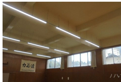
柔剣道場天井改修（完成）
