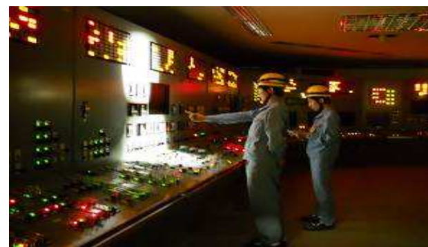
図10 室内照明全消灯時における可搬型照明の点灯状況
