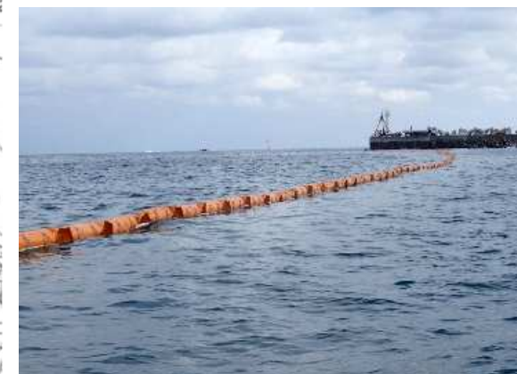
シルトフェンス設置イメージ図
