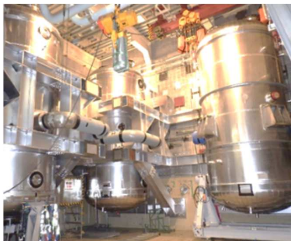
原子炉格納容器フィルタベント系
