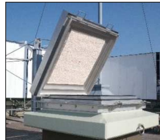
原子炉建屋ベント設備
