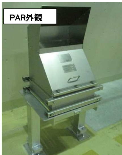
静的触媒式水素再結合装置
