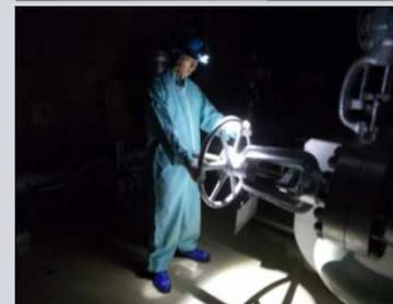
ヘッドライトを使用した状態での弁の開閉操作
