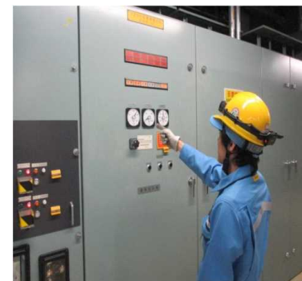
125V代替充電器の受電確認
