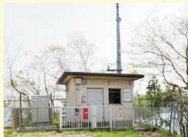
局舎内部には、測定データを保存する機器およびデータを収集・処理・送信する装置が設置されています。
