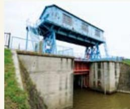
【梨ノ木水門】旧北上川から追波川への逆流を防ぐために設置された水門で、昭和30年に完成。築造年代やその機能から見て貴重な歴史的土木構造物として高く評価されている。
