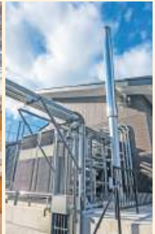
Photo/(左)リニューアルを機により見やすいレイアウトに、(右)建物内の暖房、冷房を行う木質バイオマスボイラー施設
