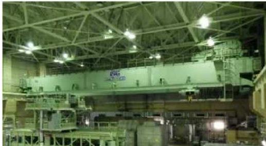
天井クレーン全景（写真）
