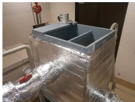
放水口モニター混合槽(2号機)
