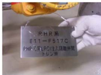
<弁への銘板の取り付け>
