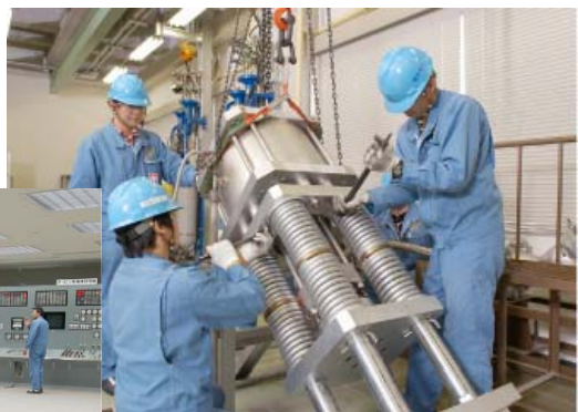
主蒸気隔離弁分解点検訓練
