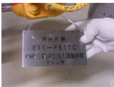
<弁への銘板の取り付け>
