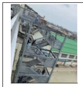
避難経路（外階段）の確認
