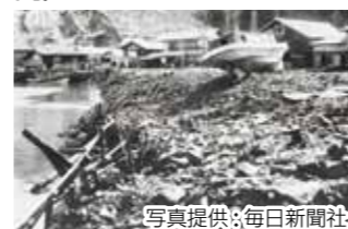
破壊された岸壁と打ち上げられた船(宮城県女川町)
