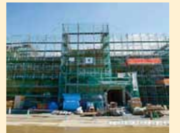
建設中の災害公営住宅
