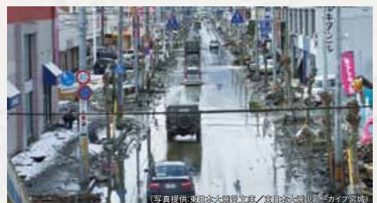
津波の被害を受けた町（気仙沼市）
