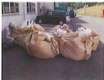
破碎した廃棄物を1m 3 大型土のうに半分(約 0.5m 3 )充填
