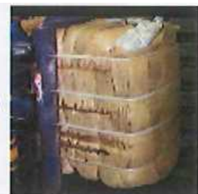
4袋分の圧縮物を1袋 の大型土のうに封入 し、バンドで結束
