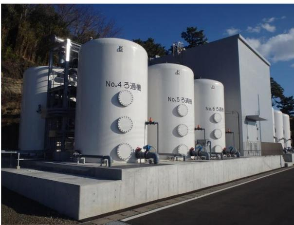
取水した海水を汲み上げ、ろ過して施設に供給します。
