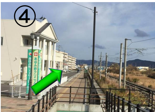
④駅から線路沿いの歩道を直進。
