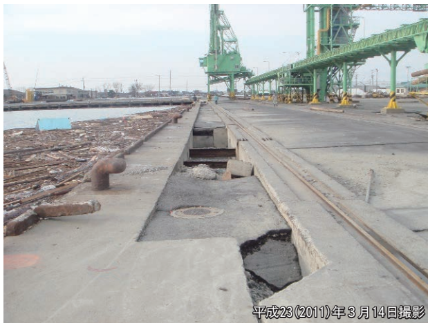
岸壁の沈下、原木漂流物 (日和埠頭)
