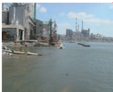
製紙会社護岸の被災状況
