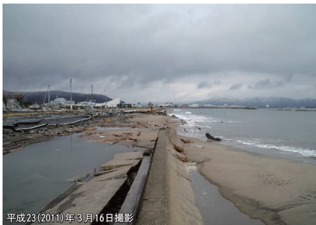
防潮堤の決壊、背後用地の洗掘(東浜防潮堤)
