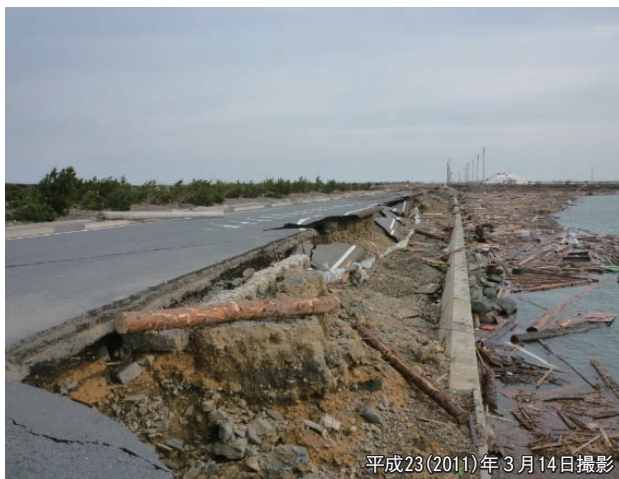
路面亀裂、段差陥没 (雲雀野中央線)
