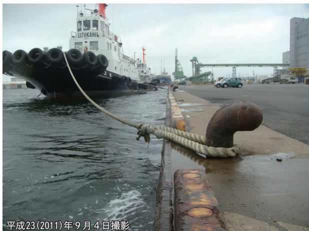
地盤沈下に伴う防舷材の水没(日和埠頭)
