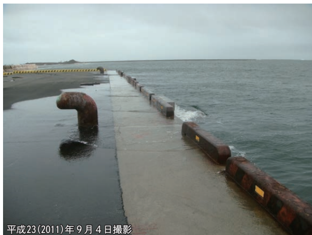
低気圧通過後の風浪による浸水(雲雀野中央埠頭)
