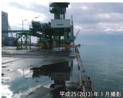
日和岸壁改修前
