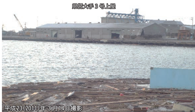
県営大手3号上屋の被災状況
