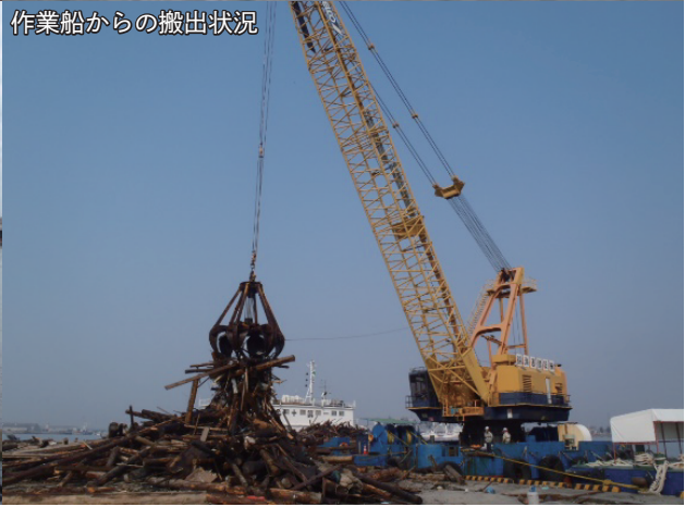
作業船による障害物の引き上げ回収作業
