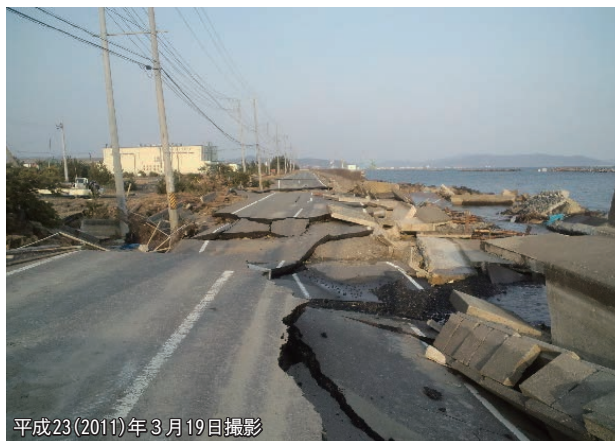
防潮堤の決壊、背後道路の崩落(西浜防潮堤)
