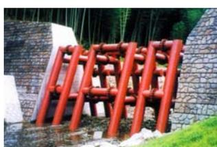
鋼管フレーム構造
