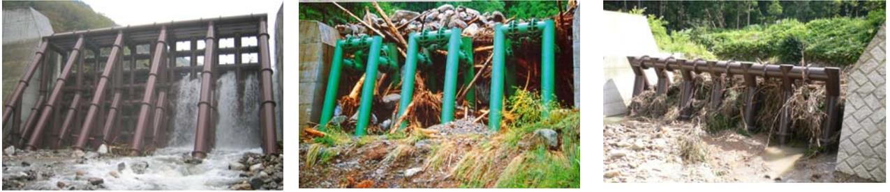
写真 2. 土石流・流木捕捉事例
