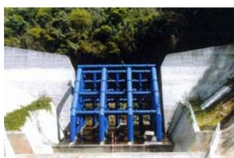
鋼管フレーム構造
