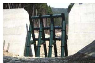
鋼管フレーム構造
