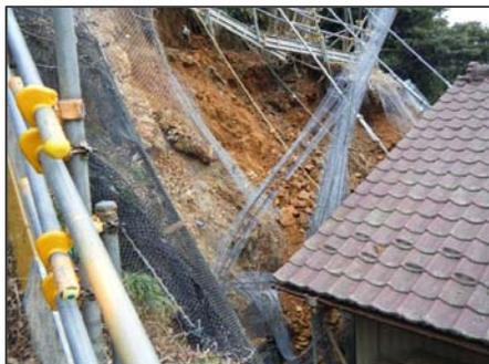
■崩壊した法枠施工現場の斜面
