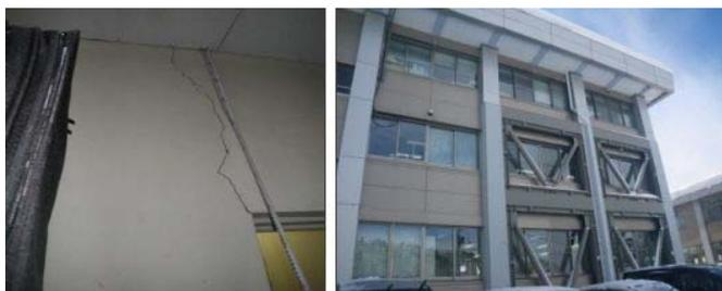
■地震で発生した庁舎壁のひび割れ ■耐震補強した庁舎
