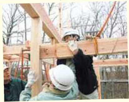
3 納得いくまで木組みにこだわり自ら建て方作業も手がける
