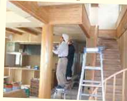
4 塗り壁工事、身体にやさしい仕上げ材の一つです。
