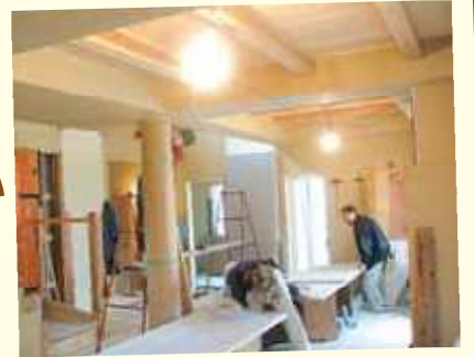
3 造作工事、ほとんど無垢材で構成されています。
