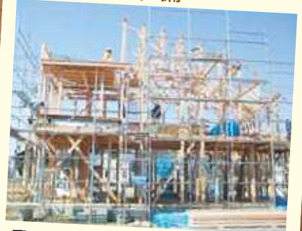
1 県産材による構造躯体、宮城の風土に最も適していると考えます。
