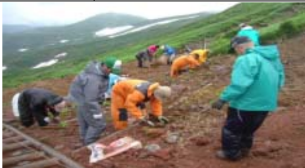
栗駒国定公園 (雪田ボランティア植栽作業)
