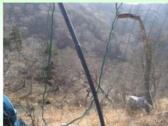
防鹿柵ネットの補修が必要な状況
