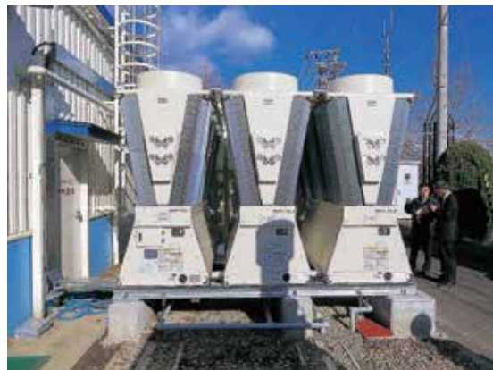
過去の補助事業より（空冷ヒートポンプチラー）
