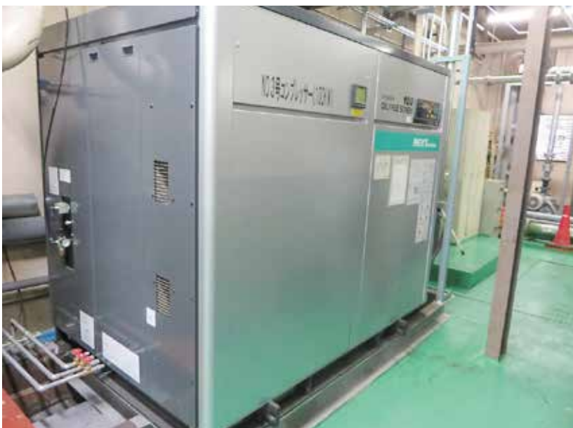
平成 26 年度補助事業より（コンプレッサー）
