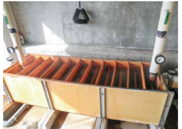
遠刈田地区に設置された熱交換器
