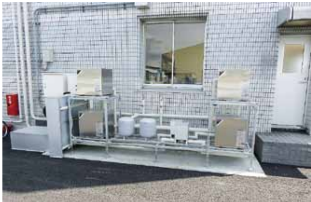
地中熱利用設備
