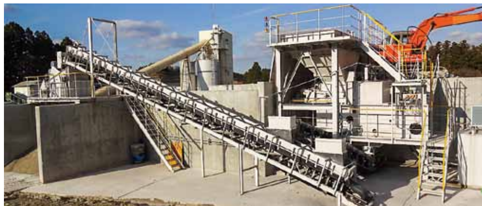
再生コンクリート破碎設備
