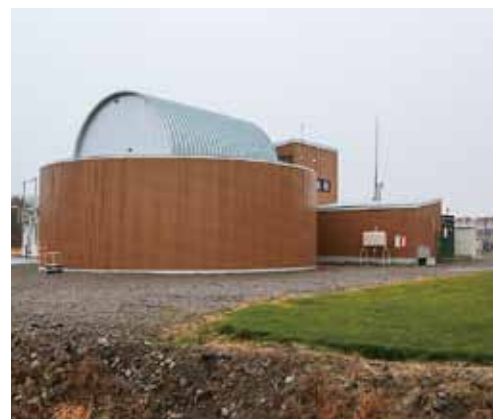
バイオマスプラント
