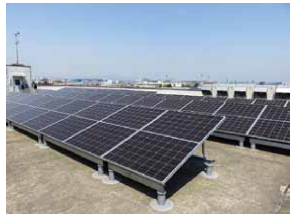
太陽光発電設備
