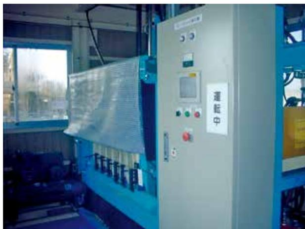
▲新設したフィルタープレス式脱水機
