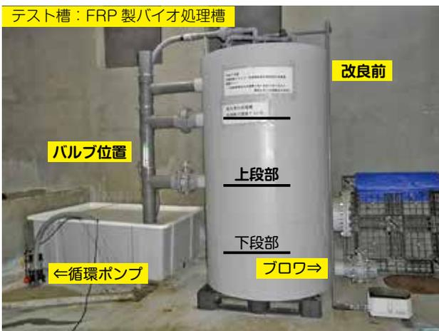
▲多種類の汚排水に対応のバイオ処理浄化槽
