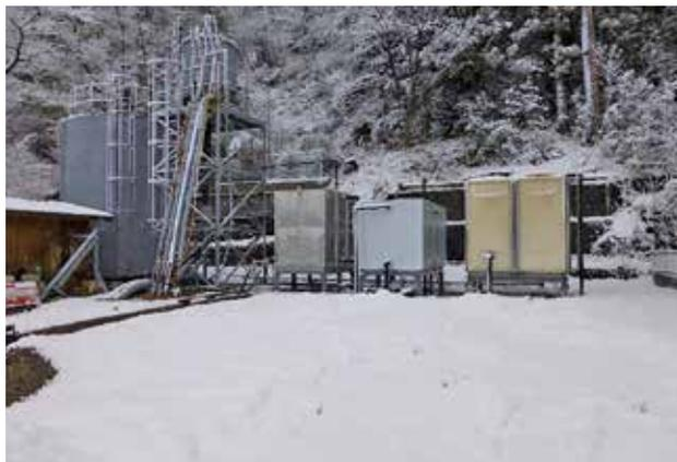
▲源泉タンク右のスペースに熱交換用タンク、水道水(上がり湯)タンク、冷却水タンクを設置
