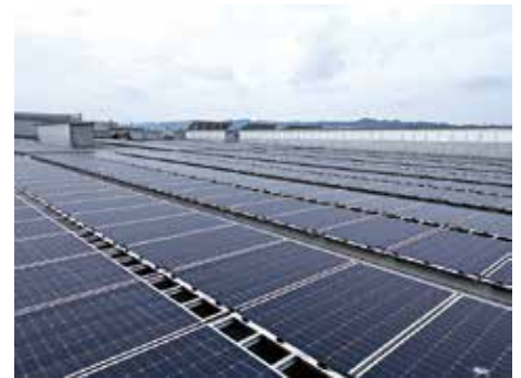
▲太陽光パネル設置写真
