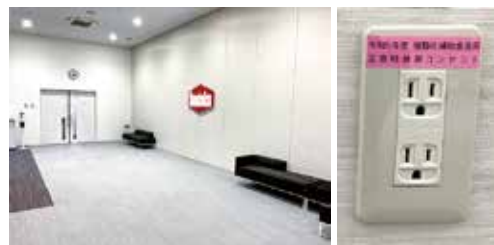
▲避難スペースと電気提供
