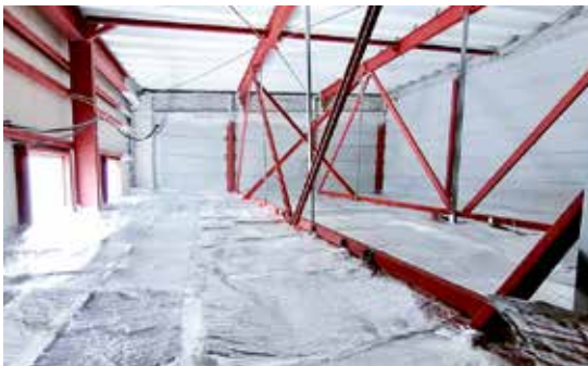
▲天井裏の遮熱施工後
