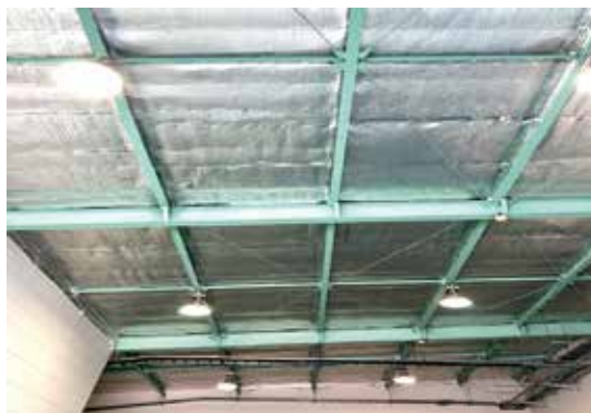
▲天井の遮熱施工後
