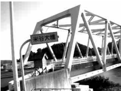
〈登米市東和町 米谷大橋〉
