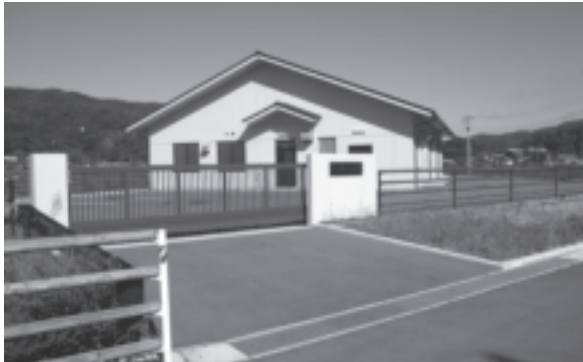
▲米川地区汚水処理施設（登米市）
