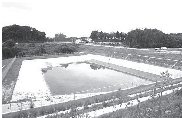
▲ 事業区域に調整池を設置し、水害防止を図っている。
