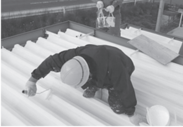
▲ 環境に優しい省エネ塗料のテスト施工の様子
