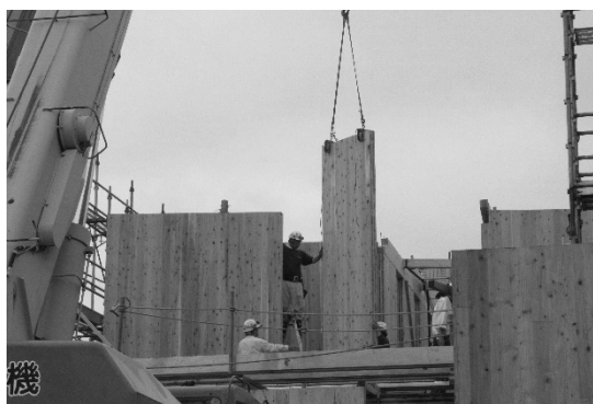
図 34：CLT を用いた建築物の建設風景 画像出典：宮城県
