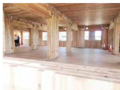
CLTで構成された建築物の骨組み
