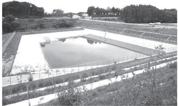
▲事業区域に調整池を設置し、水害防止を図っている
