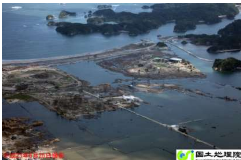
写真 3.8 壊滅的な被害を受けた沿岸部
