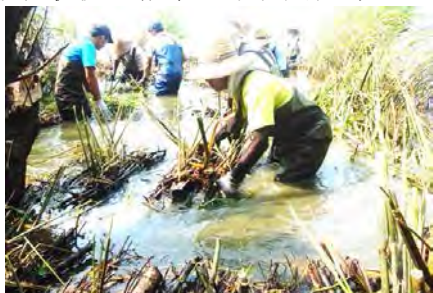
ヤナギ魚礁によるマコモ植栽作業の状況
