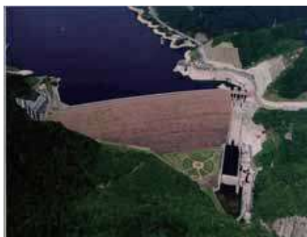
写真 3.8 七ヶ宿ダム（白石川）
