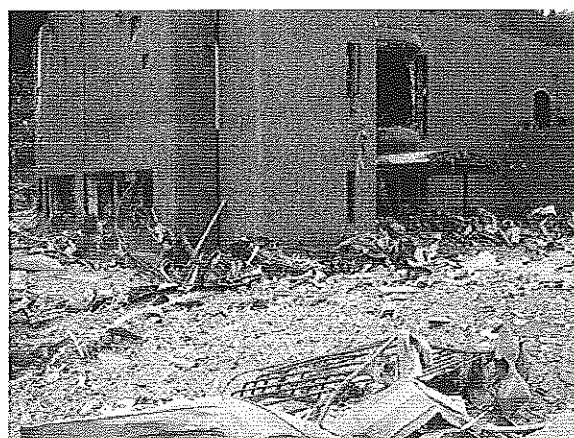
写真2 被災後の原子力センター（H23. 3. 14撮影）
