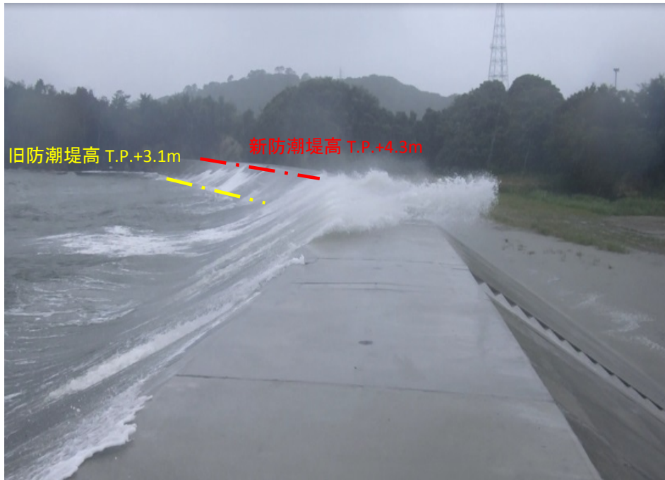
新防潮堤による高潮波浪防護状況(越波のみ)
