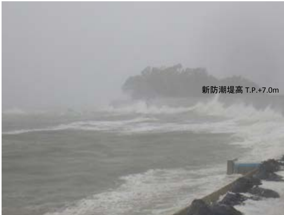
新防潮堤による高潮波浪防護状況(越波のみ)
