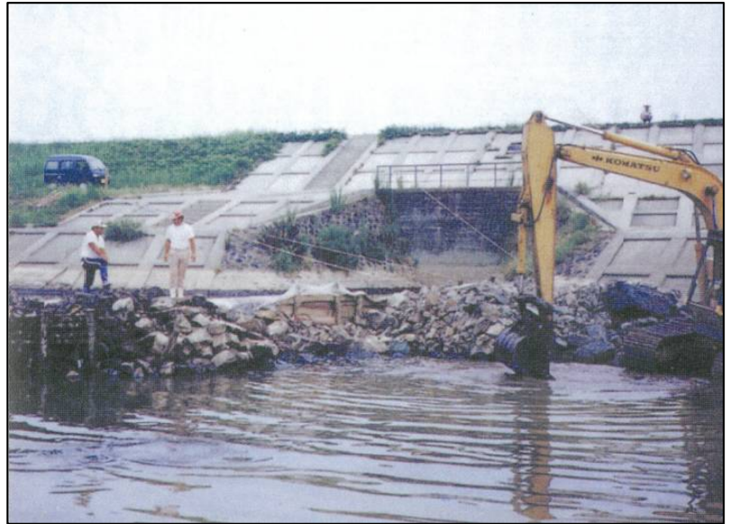
バックホウによる取水口前面の堆積土砂撤去作業 (H6.8 美里町 (旧南郷町))
