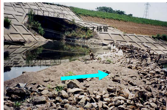
平成6年8月渇水状況写真 『かんがい：中才揚水機場取水口』
