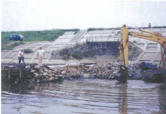
写真 2-16 かんがい取水口前面の堆積土砂
