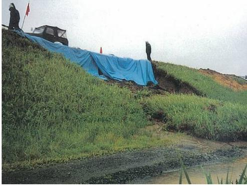
写真 2-23 堤防法崩れの状況
