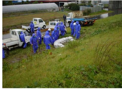
写真 2-24 漏水による水防活動の状況
