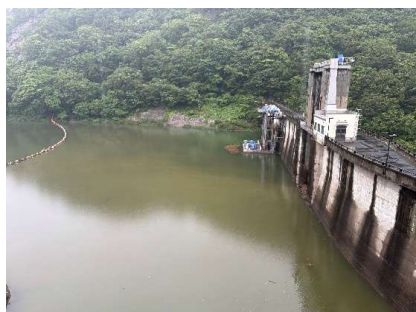
貯水池 ダム堤体上流 (撮影:6月21日7時30分)
