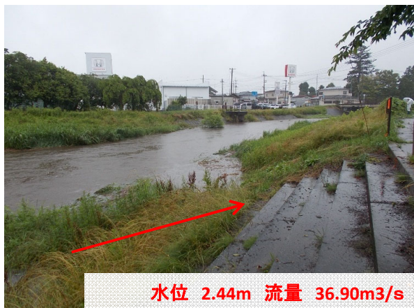
大水門水位観測所(洪水後 7月12日9時00分)
