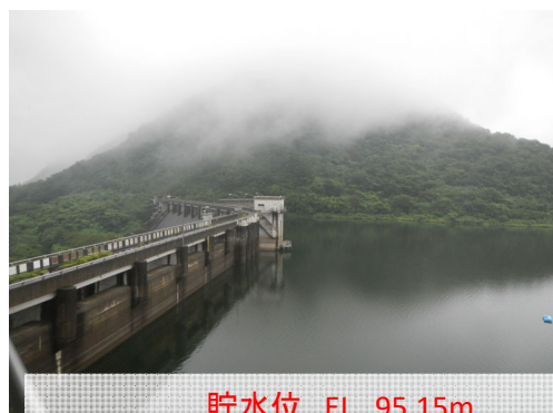
ダムの状況写真
