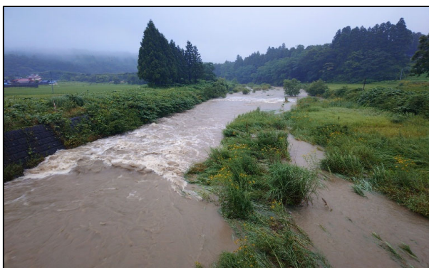
水位 0.59m 流量 42.02m 3 /s 橋元水位観測所(洪水中 8月1日 4時50分)
