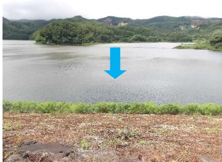
貯水位 ダム堤体上流 (撮影8月13日 12時20分)
