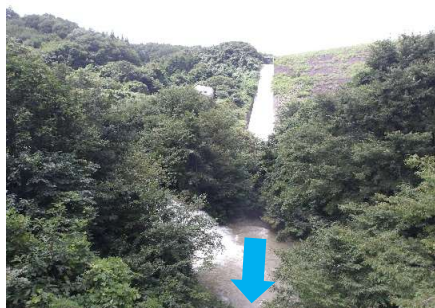
ダム堤体下流 (撮影 8月13日 12時00分)
