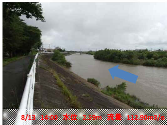
8/13 14:00 水位 2.59m 流量 112.90m 3 /s 【洪水後】花山ダム下流 若柳水位観測所(下流を望む)
